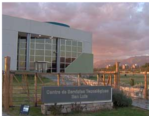
Figura N°6: Data Center San Luis
